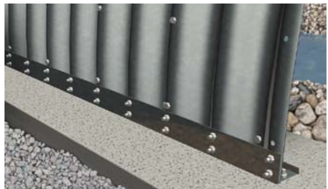
Segmentai tvirtinami prie metalinio lovio, kuris prisuktas prie betoninio pamato.
