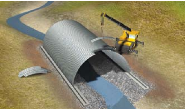
Konstrukcija surenkama po vieną lakštą
