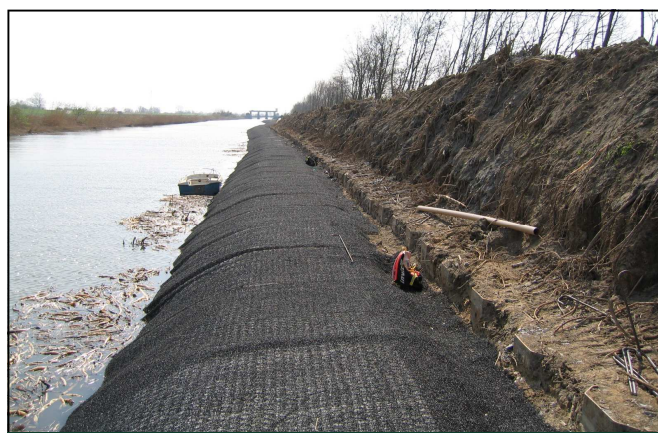
MacMat® R tvirtinimas ant upės šlaito
