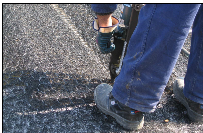
MacMat® R geokompozitų sujungimas su "hog-rings" kabėmis
