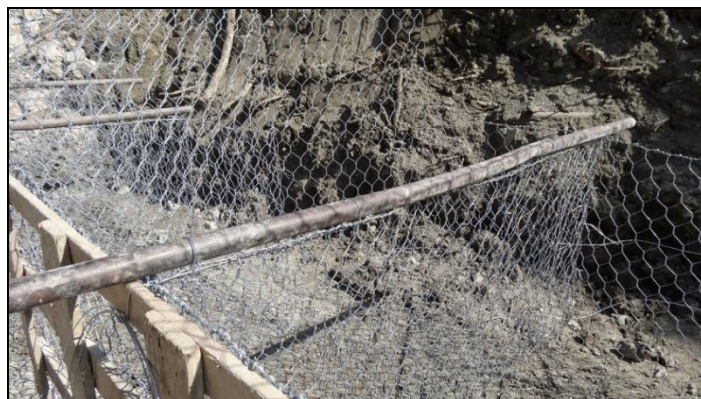
14 pav. Sienų viršutinių kraštų apsaugojimas naudojant plieninius strypus/vamzdžius.
