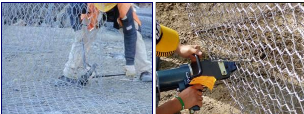
6 pav. Rankinių (kairėje) ir pneumatinių (dešinėje) žiedų užspaudimo replių naudojimas.
