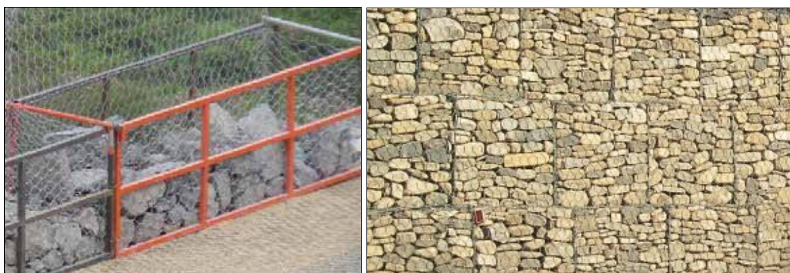
16 pav. Per dideli akmenys (kairėje) ir tinkamo dydžio akmenys (dešinėje).
