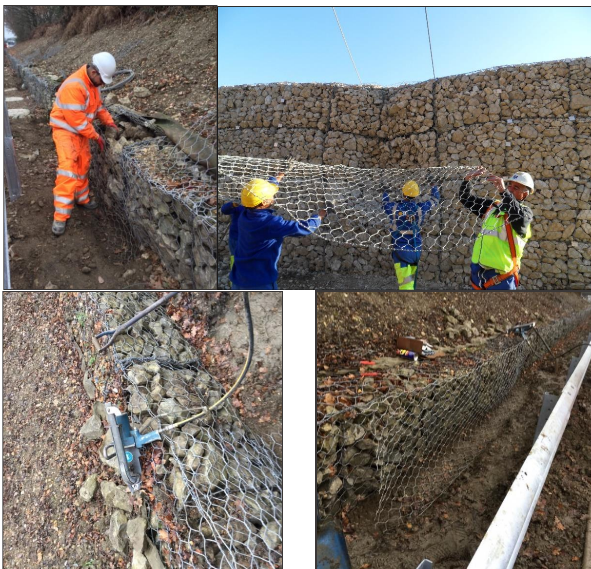
36 pav. Įdubų ir sienos pažeidimų remontas.
