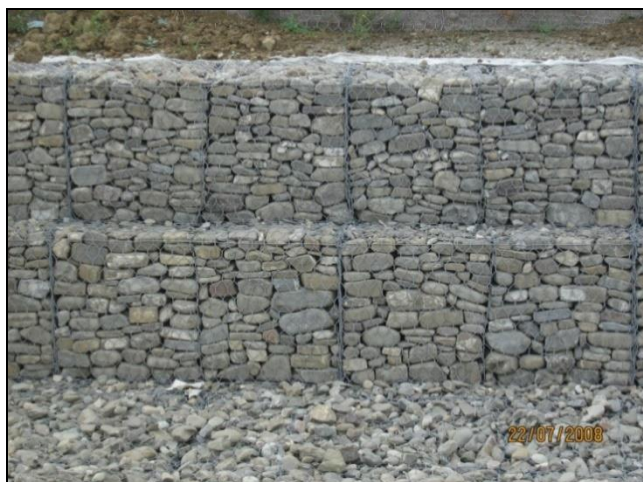
24 pav. Gabionų blokų išdėstymas, dešinėje - „mūro principu“.
