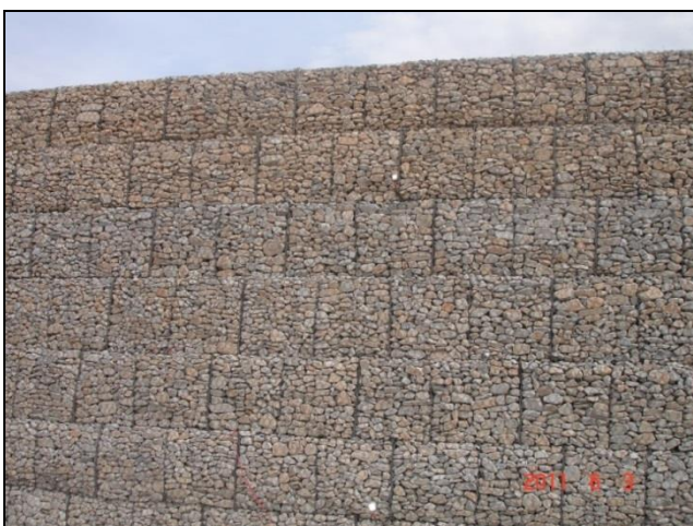
24 pav. Gabionų blokų išdėstymas, dešinėje - „mūro principu“.
