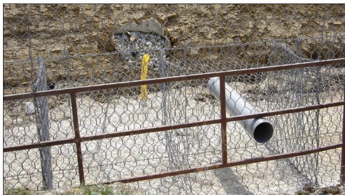
30 pav. Gabioną kertantis nedidelio skersmens vamzdis.
