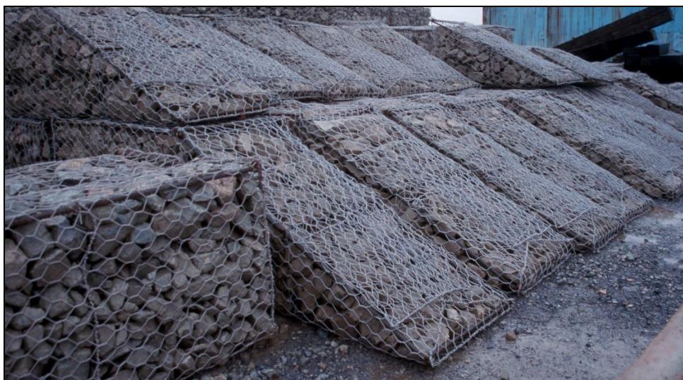
5 pav. Gabionų formavimas.
