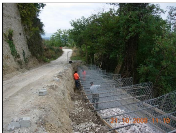
4 pav. Gabionų padėtis: visų gabionų dangčiai atlenkti, orientuoti statmenai kelio atžvilgiu, kad gabionus būtų galima pripildyti mechaniniu būdu.
