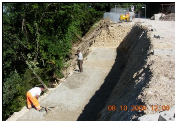
7 pav. Gabionų pagrindo išlyginimas.
