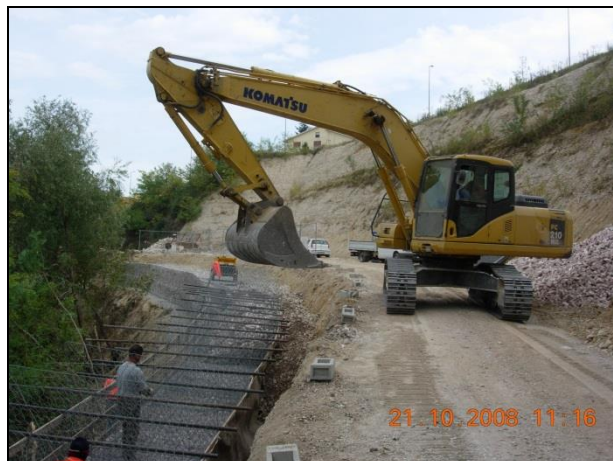
4 pav. Gabionų padėtis: visų gabionų dangčiai atlenkti, orientuoti statmenai kelio atžvilgiu, kad gabionus būtų galima pripildyti mechaniniu būdu.
