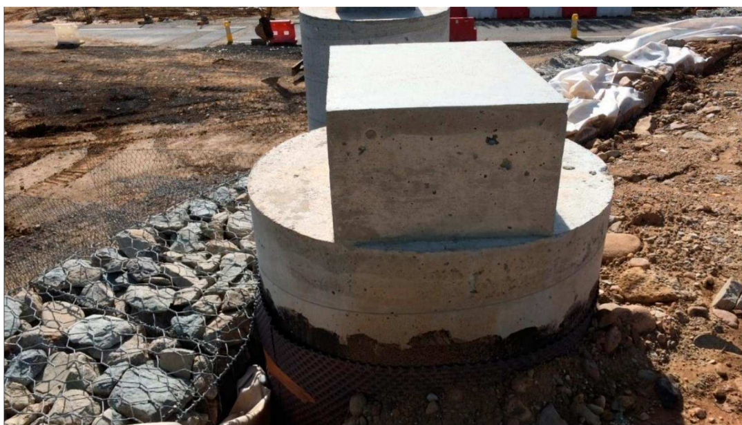
38 pav. Armuoto grunto konstrukciją kertantys atraminiai poliai.
