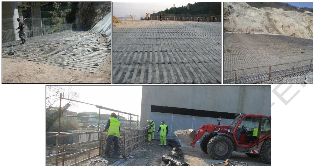
12 pav. Terramesh sistema, papildomai suarmuota geotinklu.
