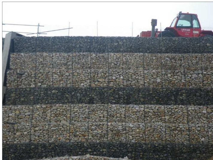
26 pav. Vertikaliai tiesiai sulygiuoti „Terramesh“ blokai.
