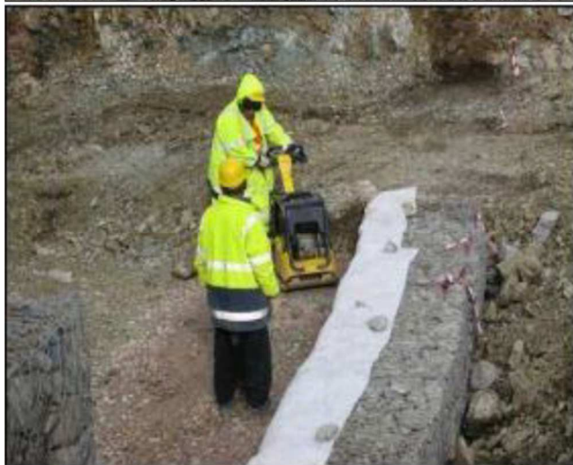
33 pav. Šalia sienos (1,0 m atstumu) turi būti naudojami mažo svorio tankinimo įrenginiai.
