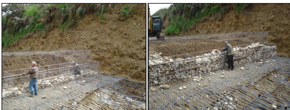
22 pav. Gabionų užpildymo eiliškumas.
