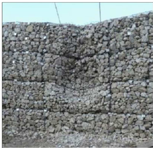
40 pav. Sienos defektai dėl smūgio (kairėje) ir dėl srovės nešamo medžio kamieno (dešinėje).
