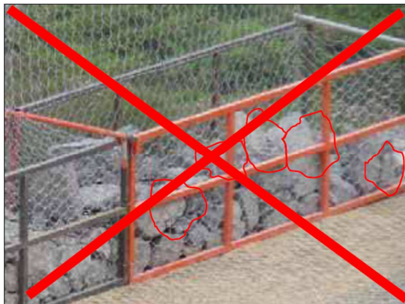
23 pav. Per dideli akmenys (kairėje) ir tinkamo dydžio akmenys (dešinėje).
