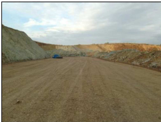
6 pav. Terramesh pagrindas: išlyginimas.
