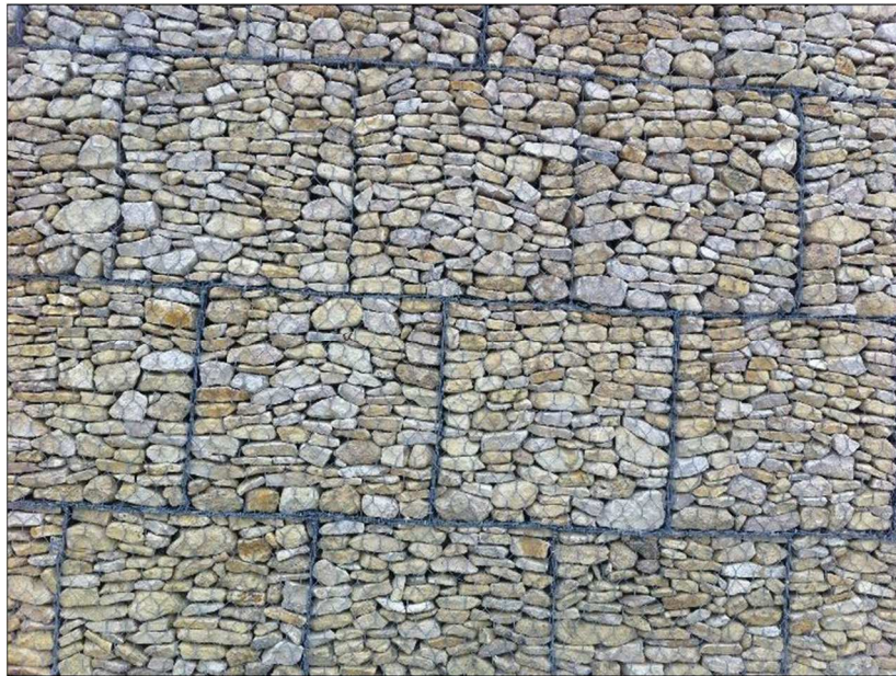
27 pav. „Terramesh“ blokų išdėstymas „mūro principu“.
