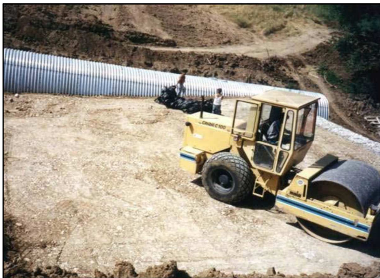
32 pav. Sunkios tankinimo mašinos negali būti naudojamos mažesniu nei 1 m atstumu nuo sienos fasado.
