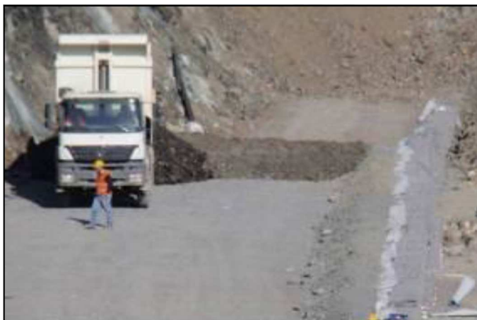
30 pav. Grunto išpylimas toliau nuo formuojamos sienos.
