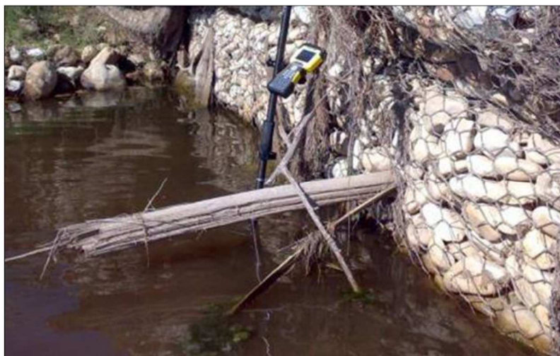
40 pav. Sienos defektai dėl smūgio (kairėje) ir dėl srovės nešamo medžio kamieno (dešinėje).
