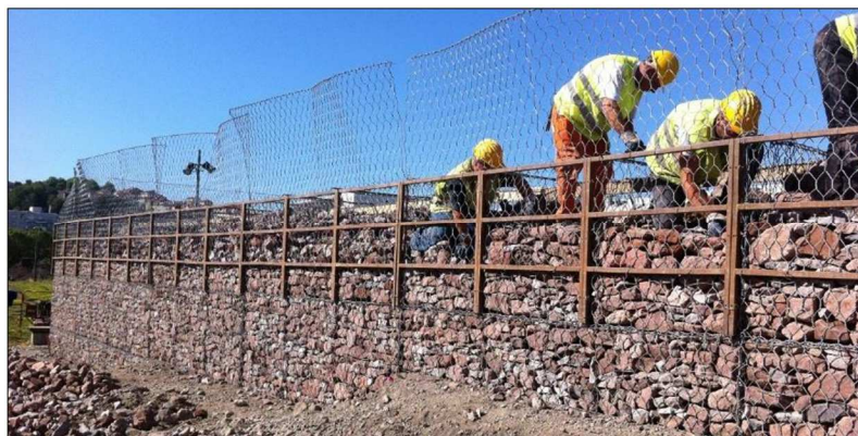
16 pav. Statybai naudojamas plieninis klojinys, neleidžiantis gabionams išsipūsti.
