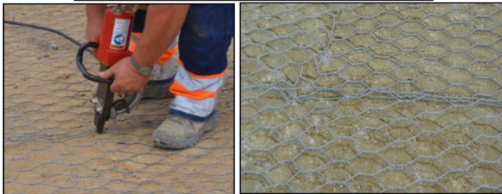
10 pav. Dviejų vielinio tinklo detalių galų sutvirtinimas žiedais, naudojant pneumatines žiedų užspaudimo reples.
