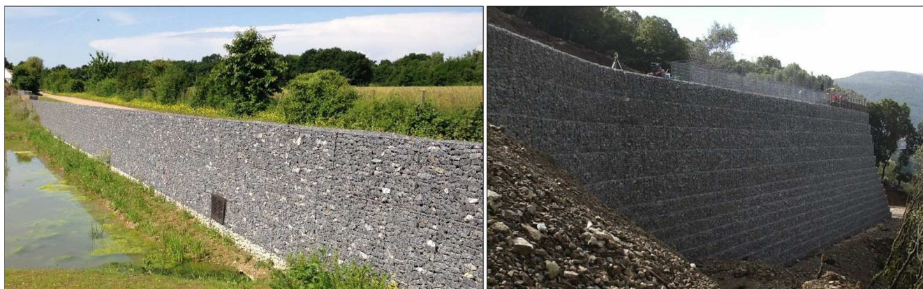
29 pav. Vertikali siena (kairėje) ir „Terramesh“ sistemos siena su šlaito kampu (dešinėje).
