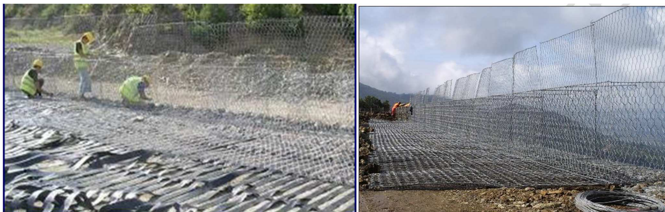
14 pav. Atskirai sutvirtintų blokų statymas į jiems numatytas vietas.
