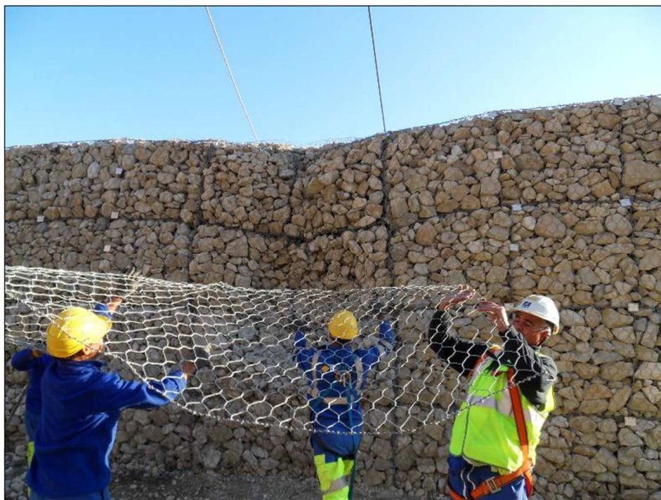
41 pav. Įdubų ir sienos pažeidimų remontas.
