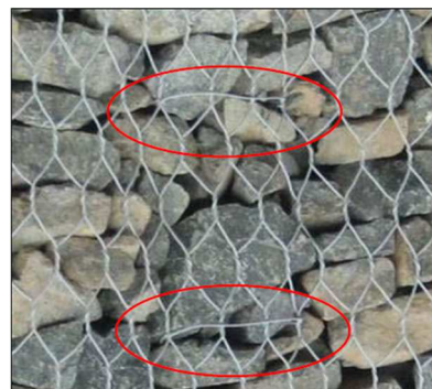
19 pav. Apjuosta 1 tinklo akis (kairėje – netinkamai apjuosta) ir apjuostos 3 tinklo akys (dešinėje – tinkamai apjuosta).
