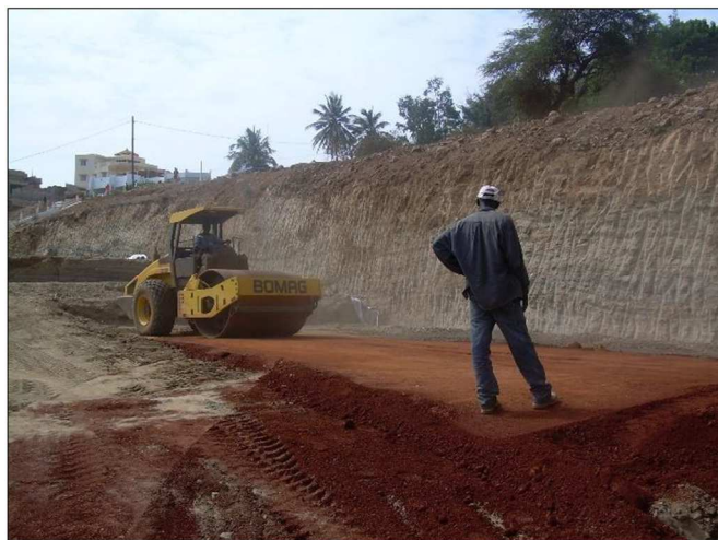
6 pav. Terramesh pagrindas: išlyginimas.
