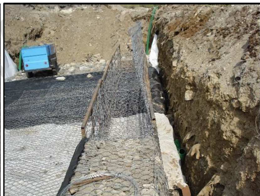
16 pav. Statybai naudojamas plieninis klojinys, neleidžiantis gabionams išsipūsti.
