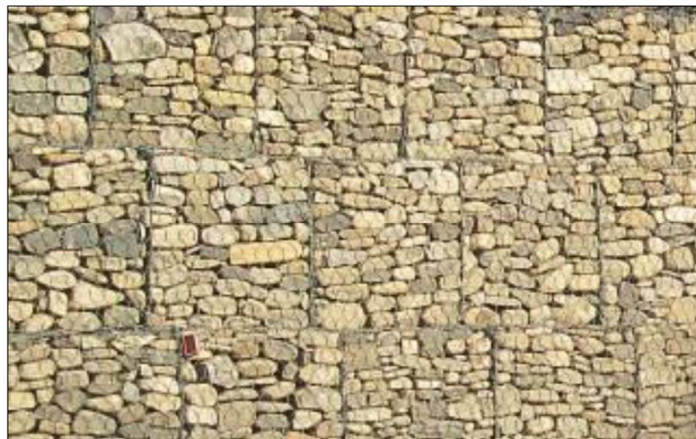
23 pav. Per dideli akmenys (kairėje) ir tinkamo dydžio akmenys (dešinėje).
