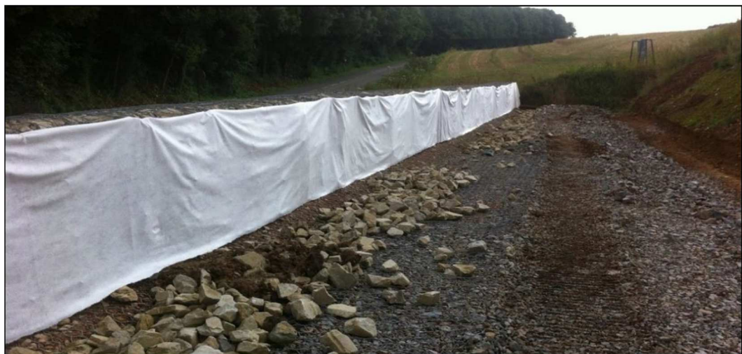
25 pav. Geotekstilės sluoksnis galinėje gabionų sienos pusėje.
