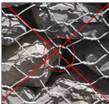
19 pav. Apjuosta 1 tinklo akis (kairėje – netinkamai apjuosta) ir apjuostos 3 tinklo akys (dešinėje – tinkamai apjuosta).
