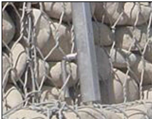
46 pav. Žemyn nulenktų kablų pritvirtinimas: užkabinimas už tinklo arba už klojinio.
