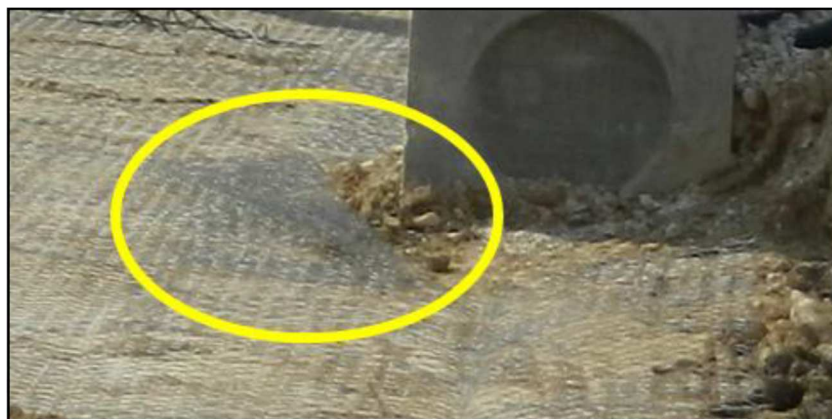
11 pav. Esant kliūtims, dvigubo pynimo vielos tinklas atlenkiamas atgal.
