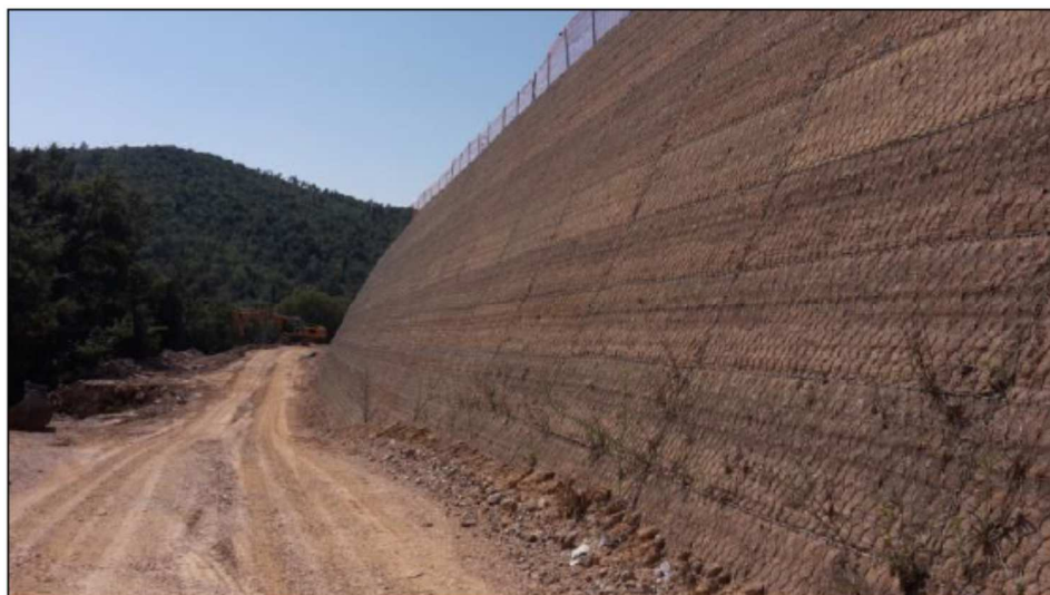
21 pav. Tiesiai vertikaliai sulygiuoti „Terramesh“ segmentai
