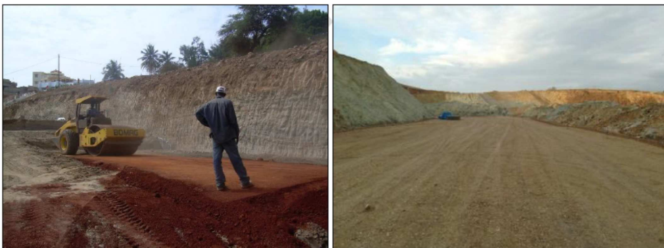
6 pav. GTM pagrindas: išlyginimas
