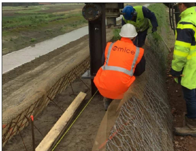
37 pav. GTM kerta triukšmo mažinimo atitvaro atraminis stulpas
