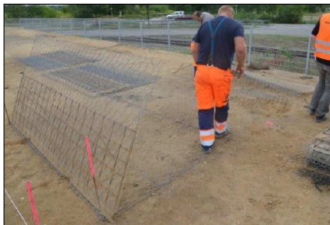
8 pav. GTM ištiesimas ir išlyginimas, kol gaunama pirminė forma
