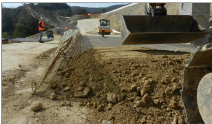
26 pav. Užpilo grunto paskirstymas
