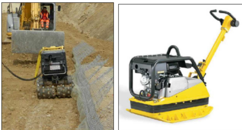
28 pav. Šalia sienos (1,0 m atstumu) turi būti naudojami lengvi sutankinimo įrenginiai
