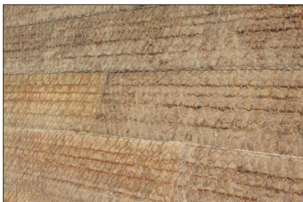
22 pav. „Terramesh“ segmentų išdėstymas „mūro“ principu
