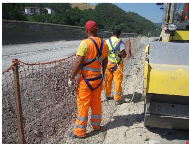
50 pav. Apsauginės įrangos patikrinimas (darbuotojas, prisirišęs prie tvirtai stovinčios įrangos)
