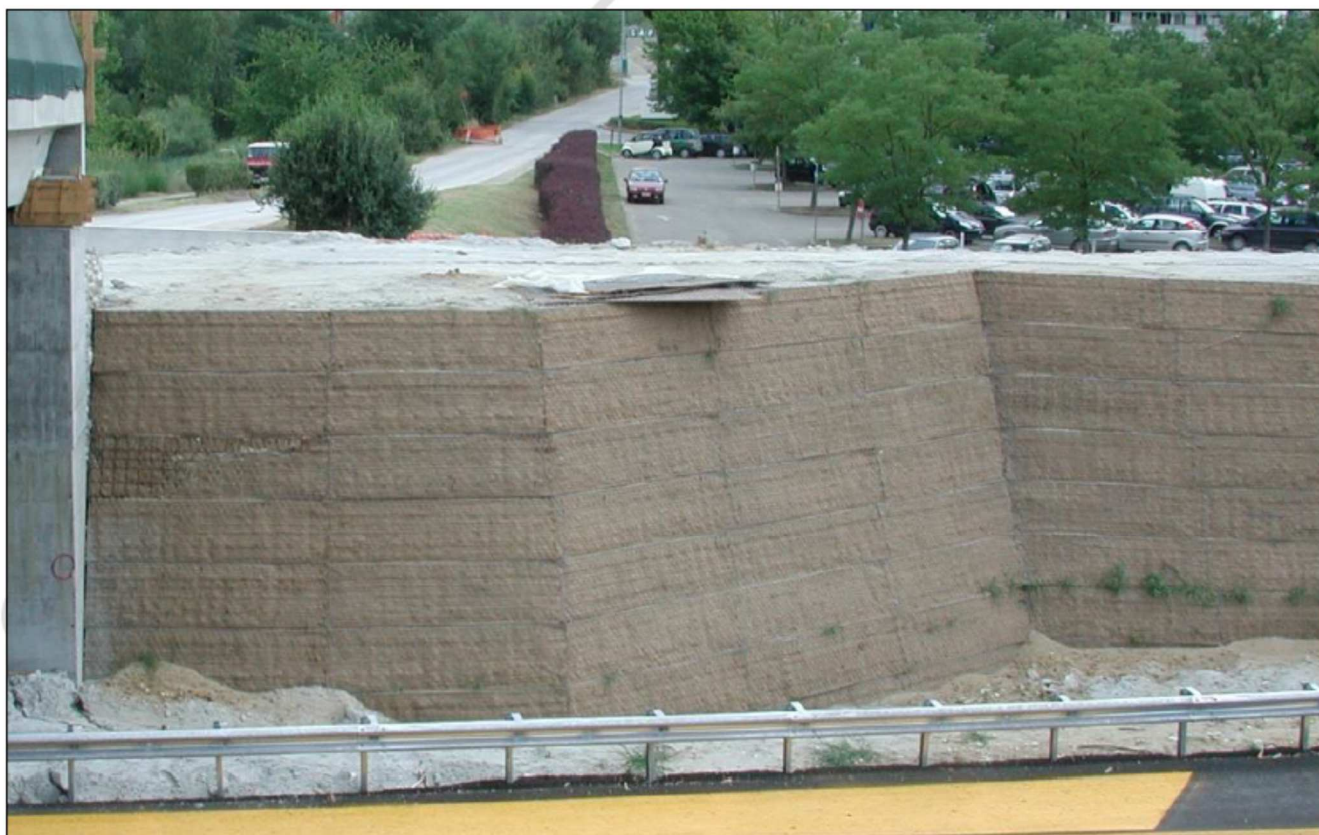
32 pav. Įgaubto arba išgaubto lanko formos statinių montavimas
