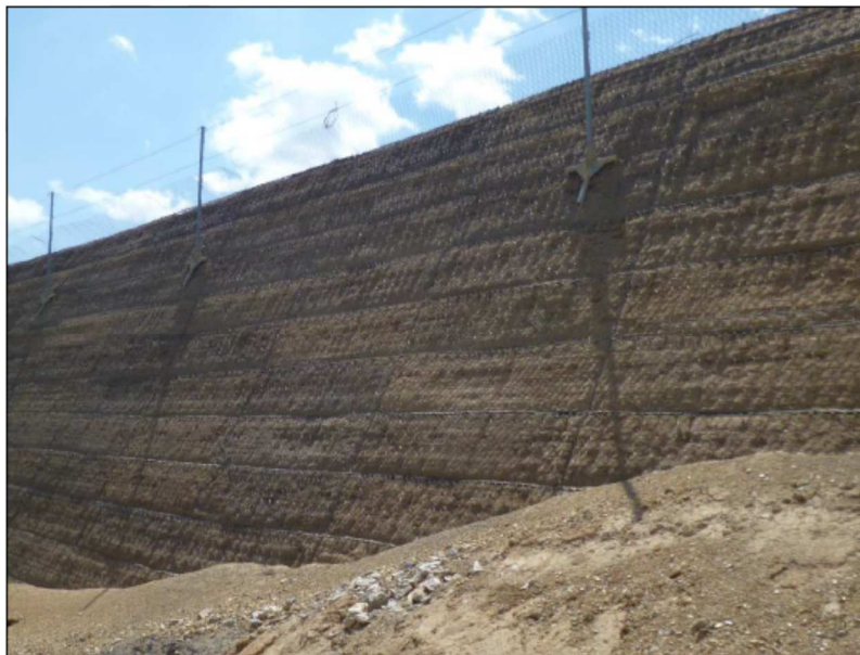
39 pav. Grunto nuolydis statinio apačioje, skirtas vandeniui nutekėti
