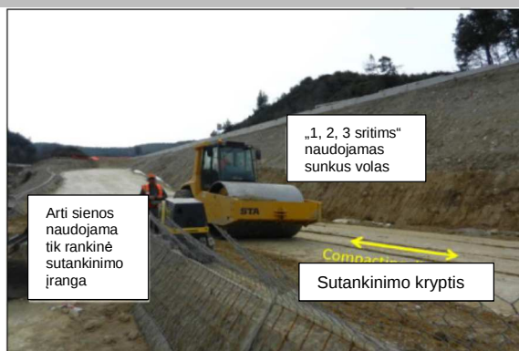
27 pav. Užpilo grunto sutankinimas
