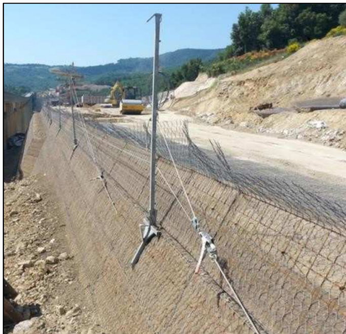
44 pav. Apsauginė įranga ant GTM sistemos segmentų
