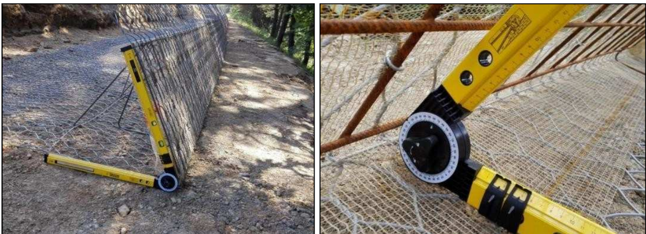
11 pav. Sienelės pasvirimo kampo kontrolė
