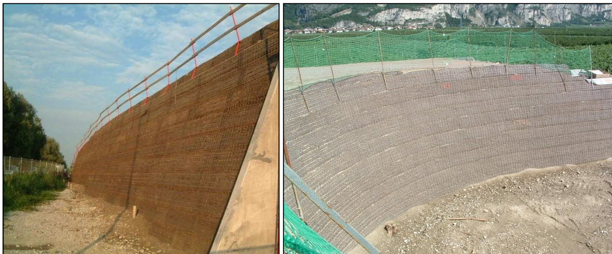
48 pav. Darbų objektas su apsaugine įranga, kur sumontuota atraminė lenta ar statyb vietės užtvartas
