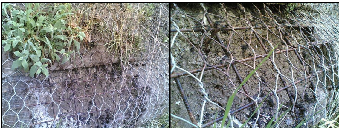
42 pav. Smulkiosioms dalelėms sulaikyti skirtos medžiagos sugadinimas gaisro atveju. Dirvožemio sluoksnis lieka atviras
