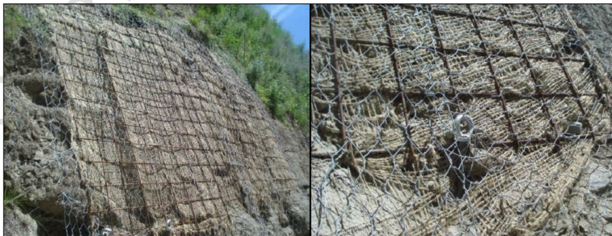
43 pav. Techninės priežiūros darbai atsiradus įduboms ar po smūgio
