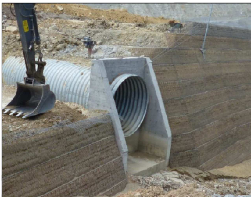
35 pav. GTM konstrukciją kertanti pralaida
