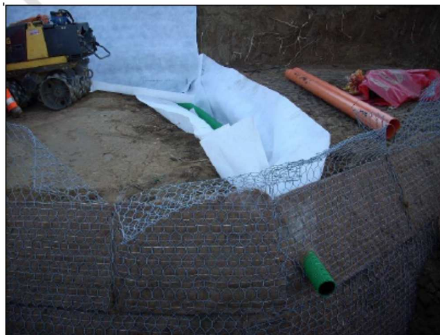
Drenažo sistema, neleidžianti atsirasti hidrostatinėms jėgoms, dėl kurių padidėja horizontalus slėgis
