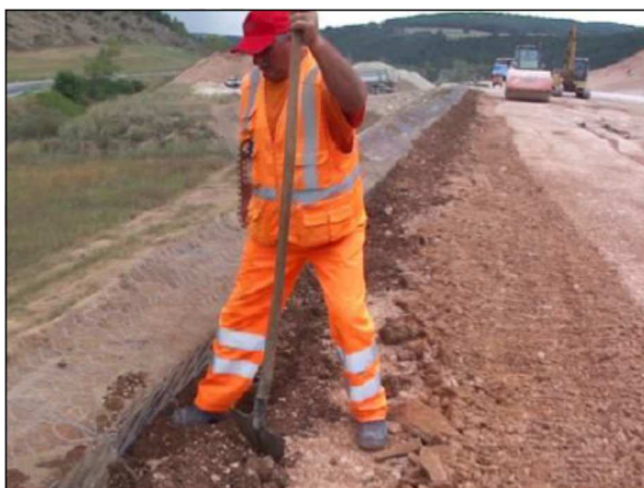
30 pav. Augalinio grunto lengvas sutankinimas
