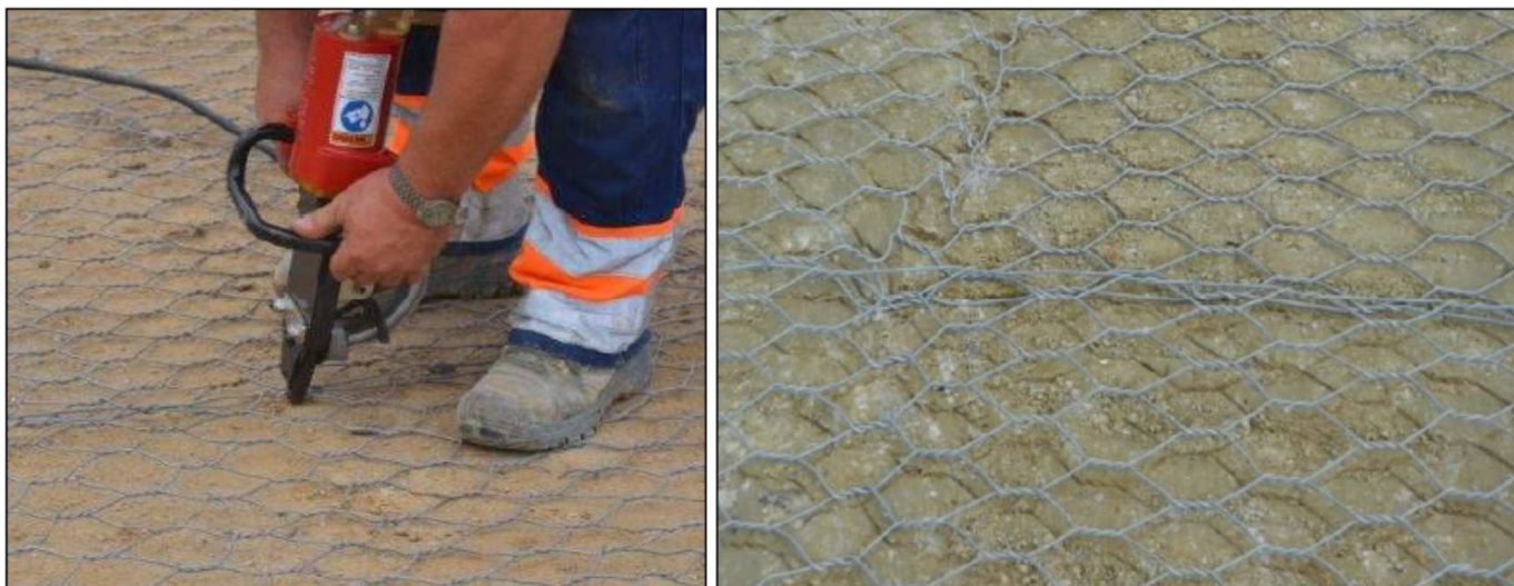
17 pav. Dviejų vielinio tinklo galų sutvirtinimas žiedais, naudojant pneumatinį žiedų suspaustuvą
