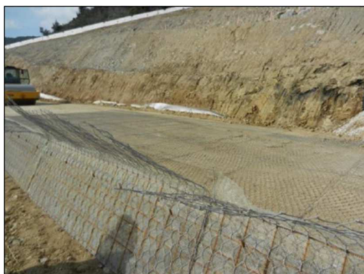
20 pav. Pirma GTM segmentų eilė paruošta sujungti viela prieš pilant statybinį gruntą
