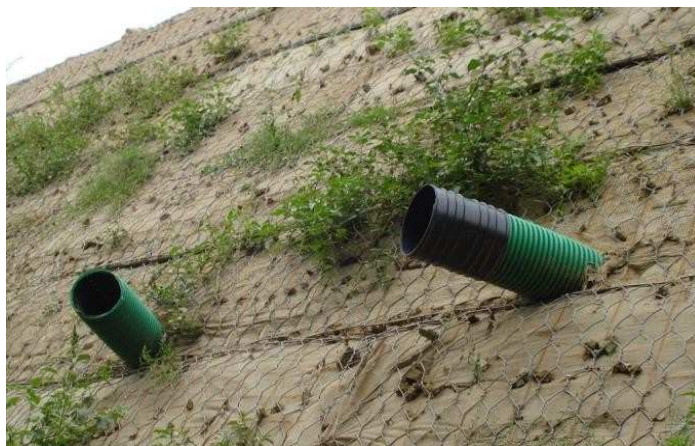
34 pav. GTM kertantys mažo skersmens vamzdžiai
