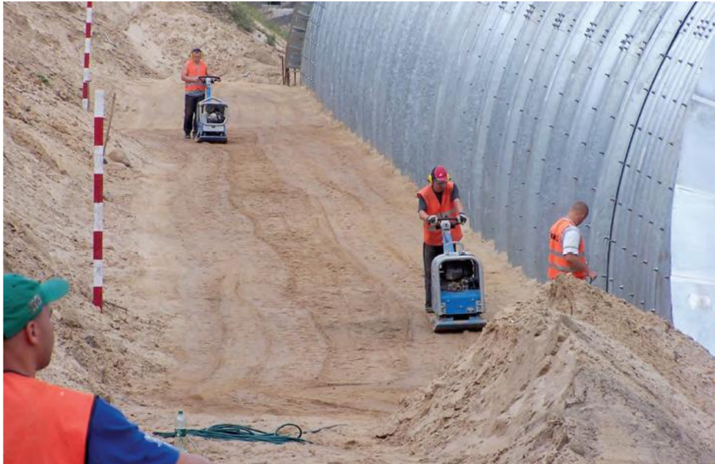
10 pav. Grunto užpylimas ir sutankinimas
