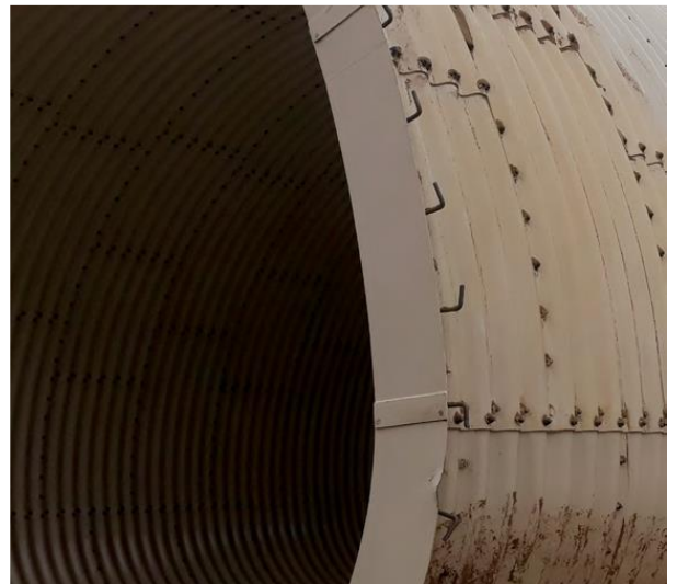
7 pav. Konstrukcijos galuose įrengiamas apvadas
