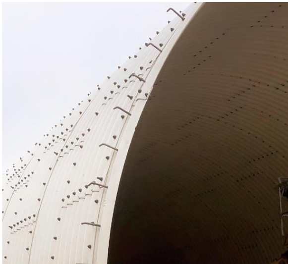
7 pav. Konstrukcijos galuose įrengiamas apvadas
