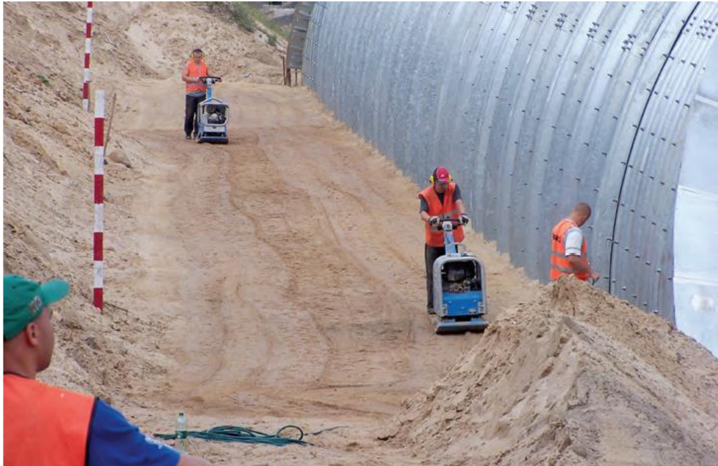
9 pav. Grunto užpylimas ir sutankinimas
